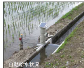
自動給水状況
