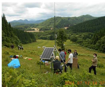
基地局の設置
