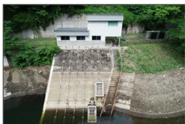
ドローンを使用し、施設状況を確認
