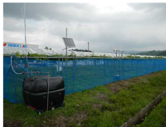
自動かん水用の太陽電池パネルと貯水タンク
